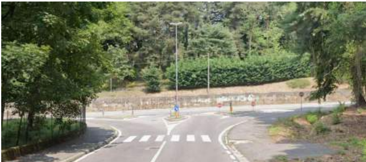
Figura 12 – Intersezione 3 – Vista dalla viabilità di comparto
