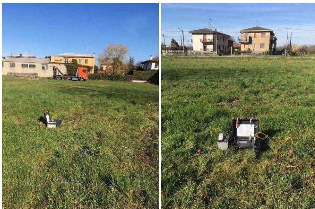
Esecuzione della prova sismica MASW
