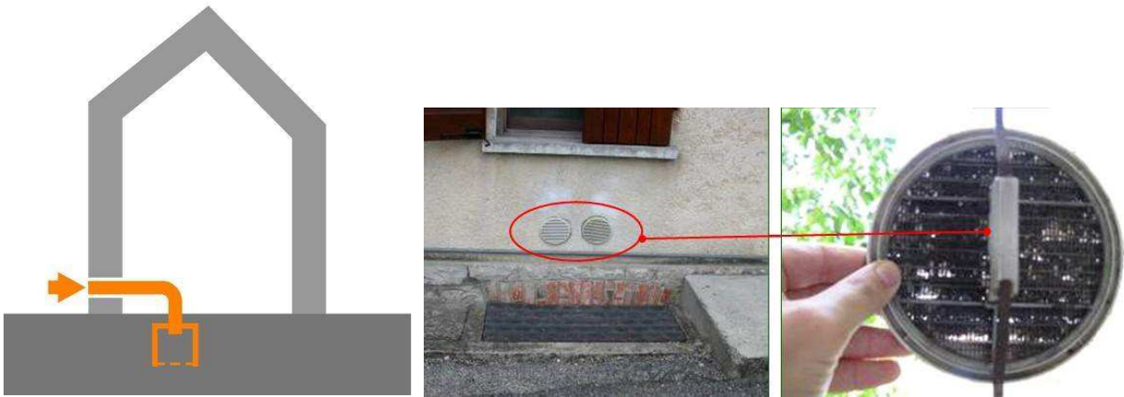
Figura 20: è necessario mantenere puliti i punti di aspirazione dell'aria
