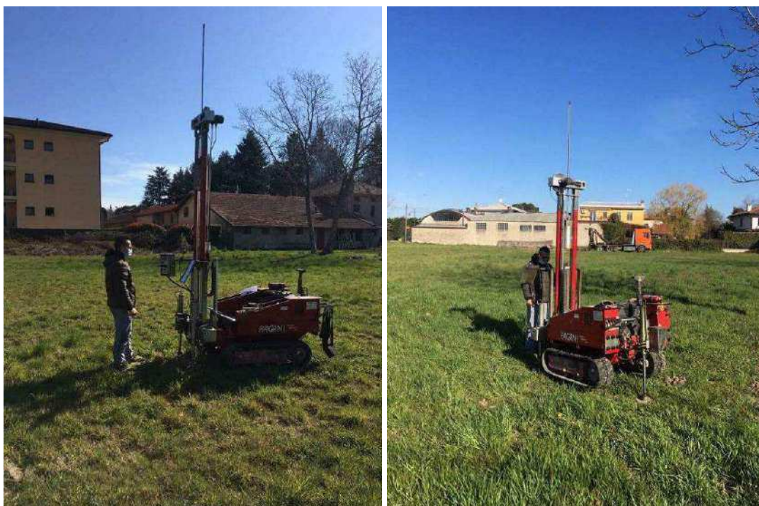
Esecuzione delle prove penetrometriche.
