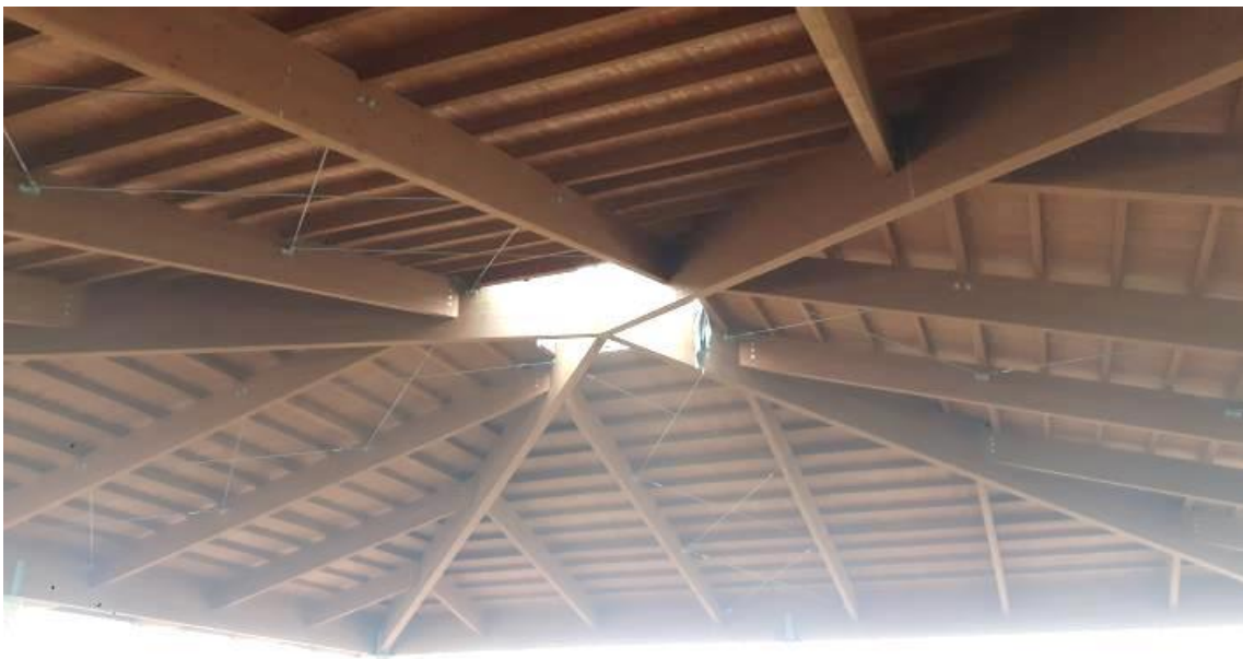
Vista interna copertura piazzetta
