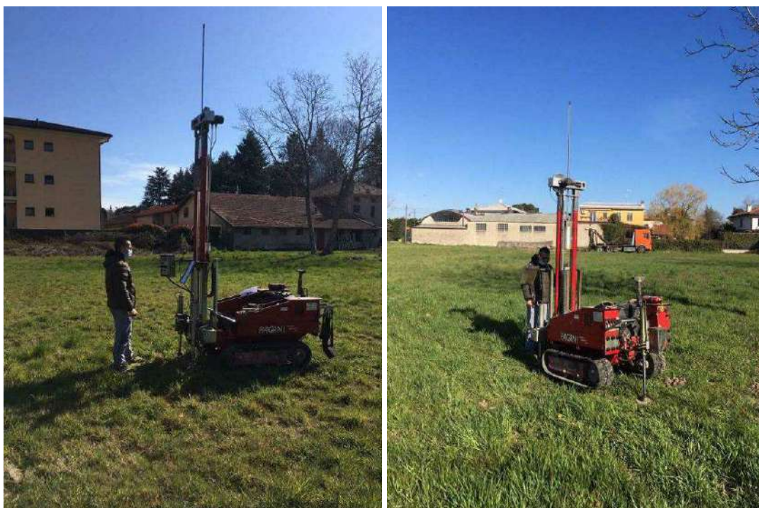
Esecuzione delle prove penetrometriche.
