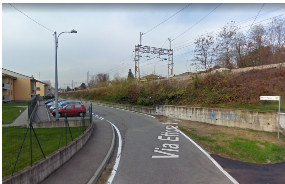
Figura 2 – Vista del rilevato ferroviario da via Viganò
