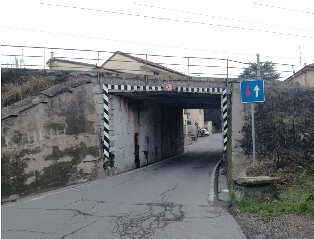
Vista imbocco Ovest
