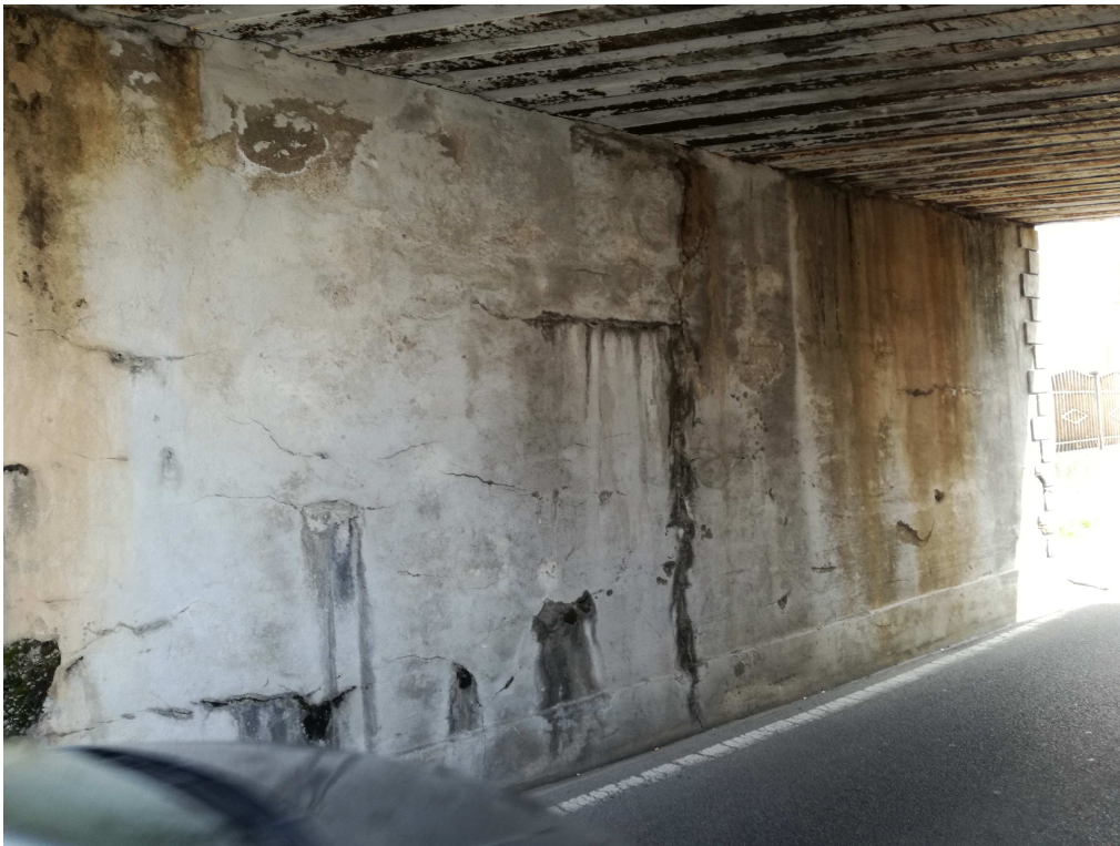
Vista spalla Nord ed impalcato
