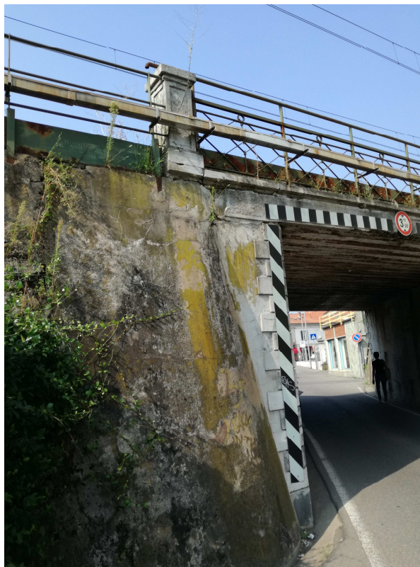
Vista muro d'ala Sud-Est
