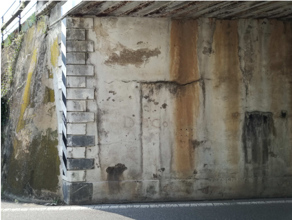
Vista spalla Sud ed impalcato
