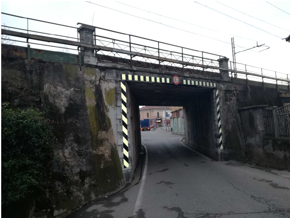
Vista imbocco Est
