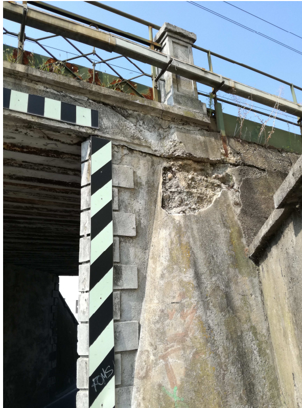
Vista muro d'ala Nord-Est
