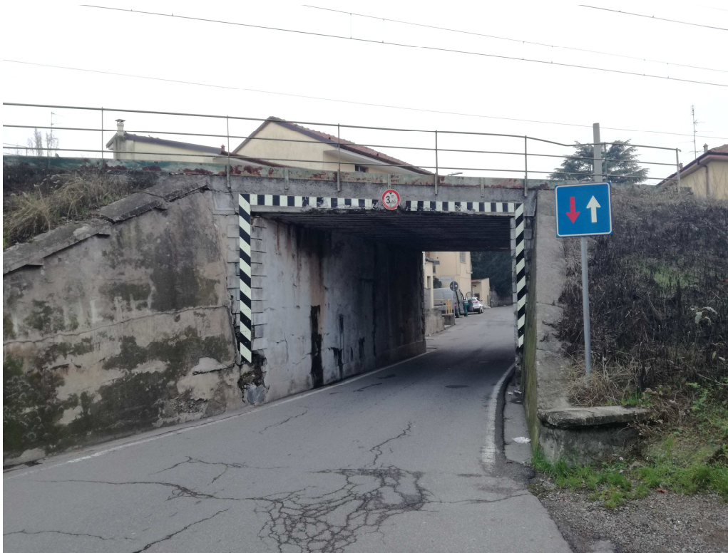
Vista imbocco Ovest
