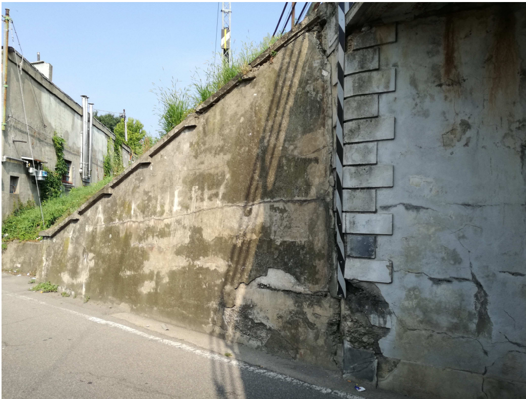
Vista muro d'ala Nord-Ovest
