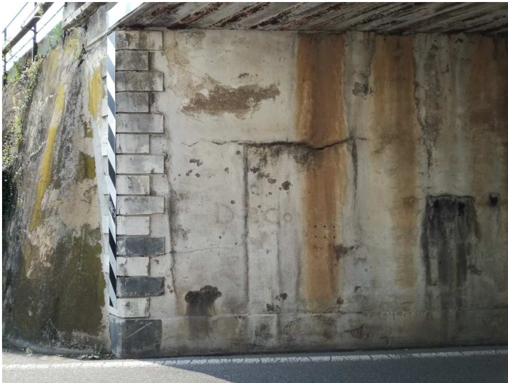
Vista spalla Sud ed impalcato
