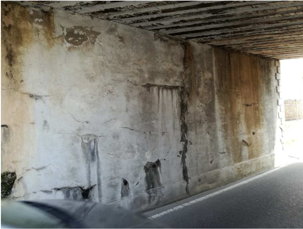
Vista spalla Nord ed impalcato
