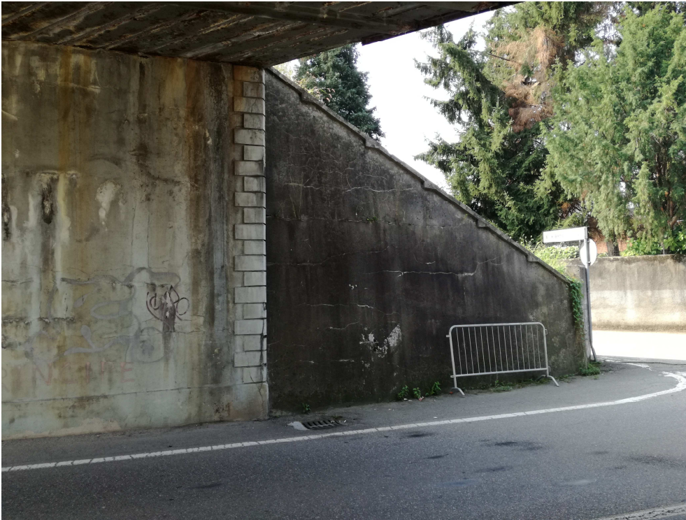
Vista muro d'ala Sud-Ovest
