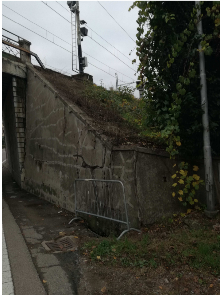
Muro d'ala Nord-Est
