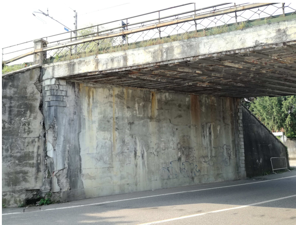
Vista spalla Sud
