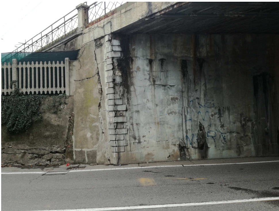
Muro d'ala Nord-Ovest e vista spalla Nord
