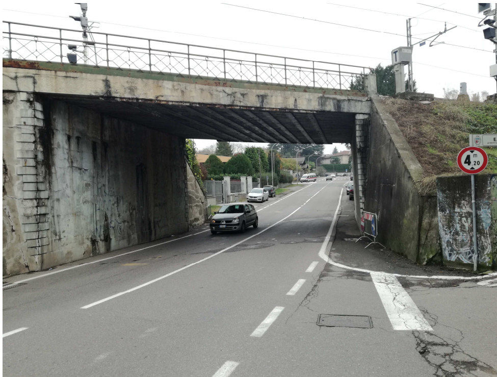
Vista imbocco Ovest
