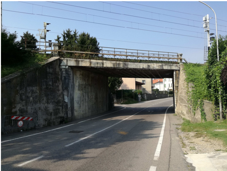
Vista imbocco Est
