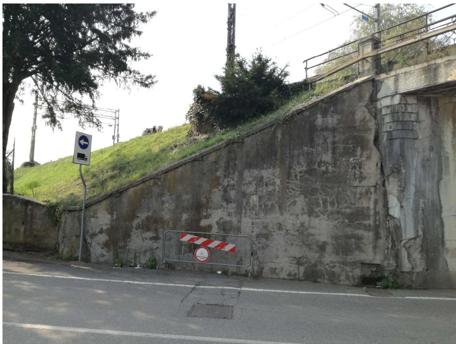
Muro d'ala Sud-Est
