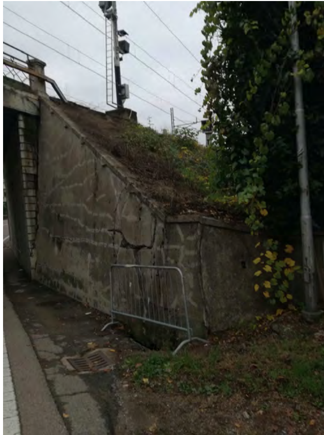
Muro d'ala Nord-Est
