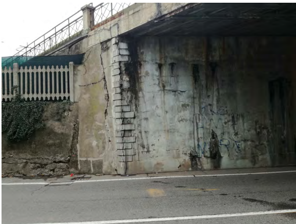
Muro d'ala Nord-Ovest e vista spalla Nord
