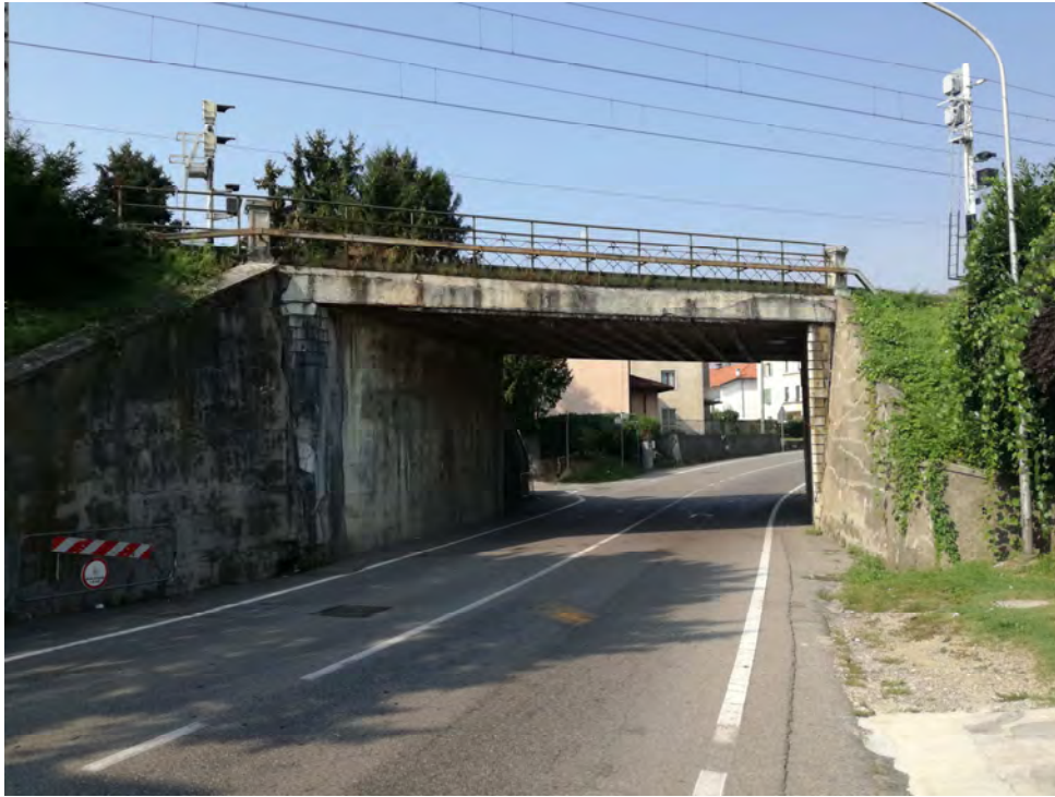
Vista imbocco Est
