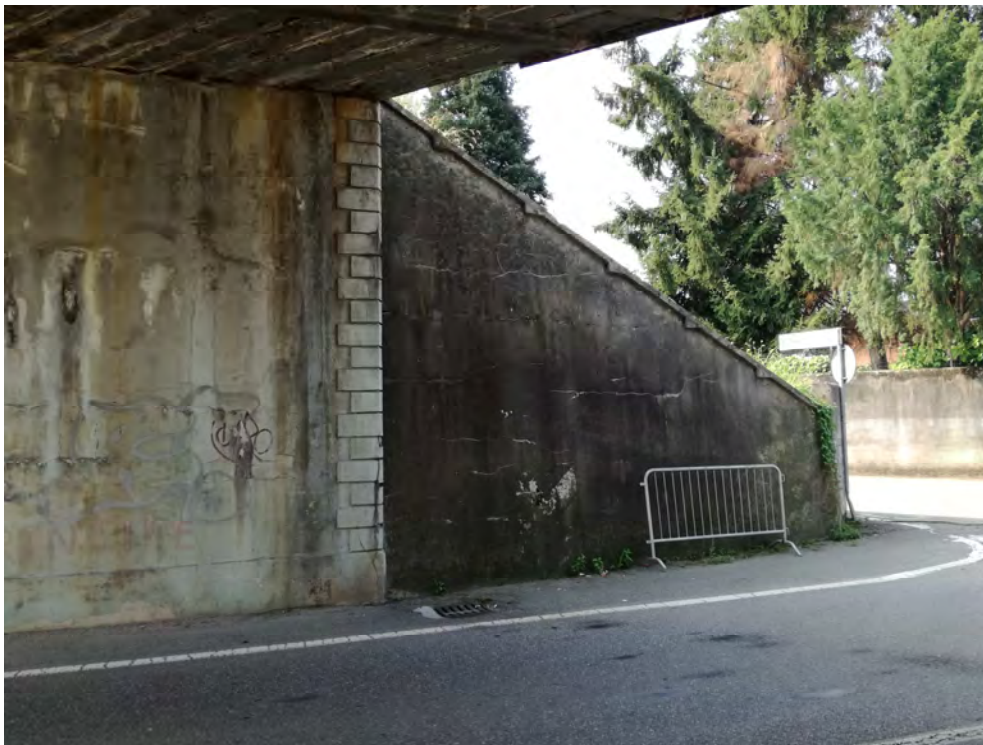
Vista muro d'ala Sud-Ovest
