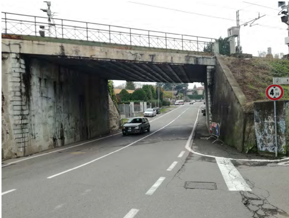
Vista imbocco Ovest
