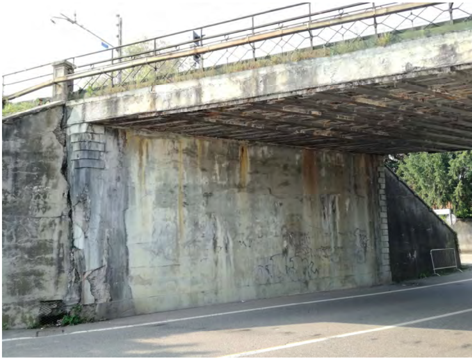
Vista spalla Sud
