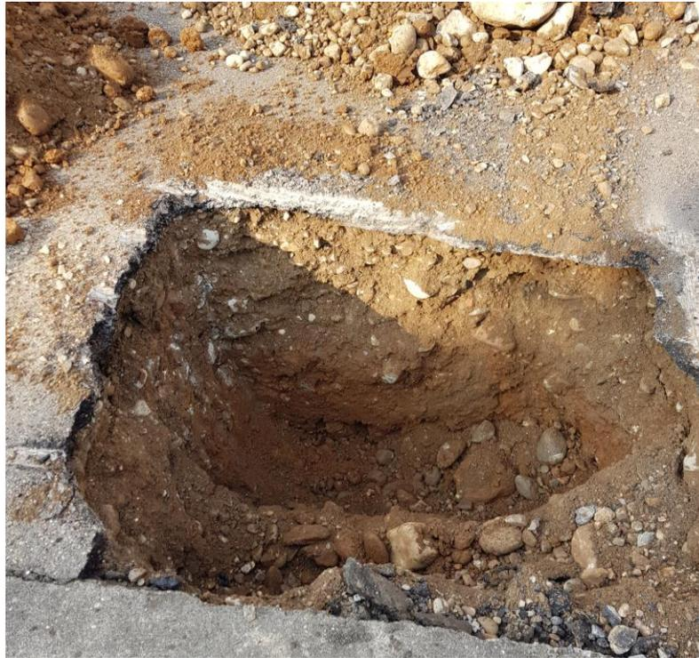
Foto 13: Esecuzione scavo 1 per prova infiltrometrica
