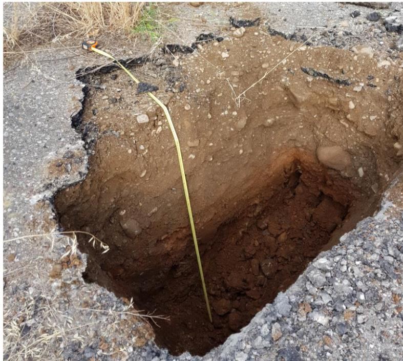
Foto 14: Esecuzione scavo 2 per prova infiltrometrica
