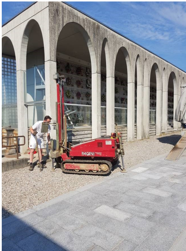
Foto 2: posizionamento ed esecuzione prova DP2
