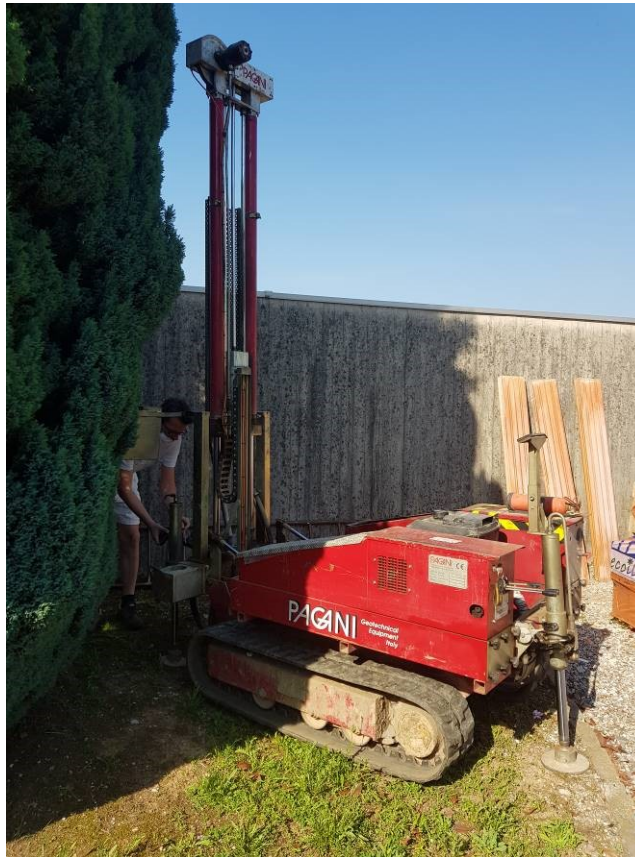
Foto 1: posizionamento ed esecuzione prova DP1
