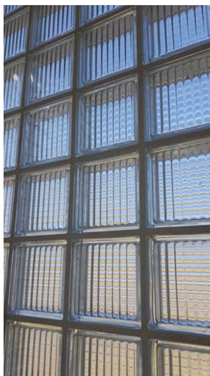
(Pannelli in mattoni di vetro dei colombari esistenti)
