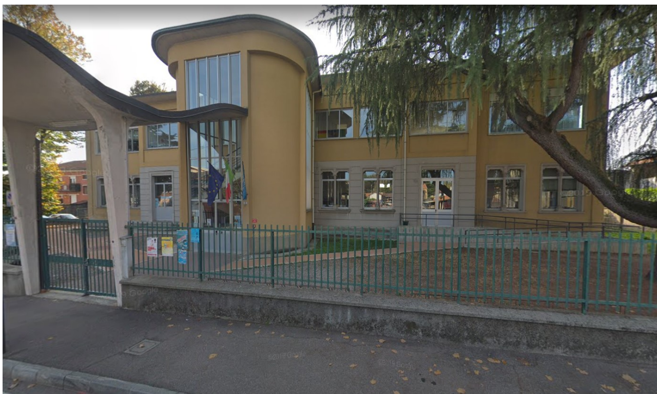
Vista facciata su via Dante
