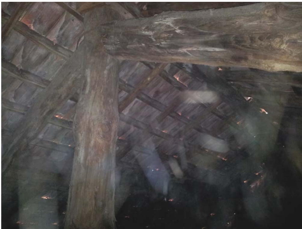
Vista sottotetto corpo centrale
