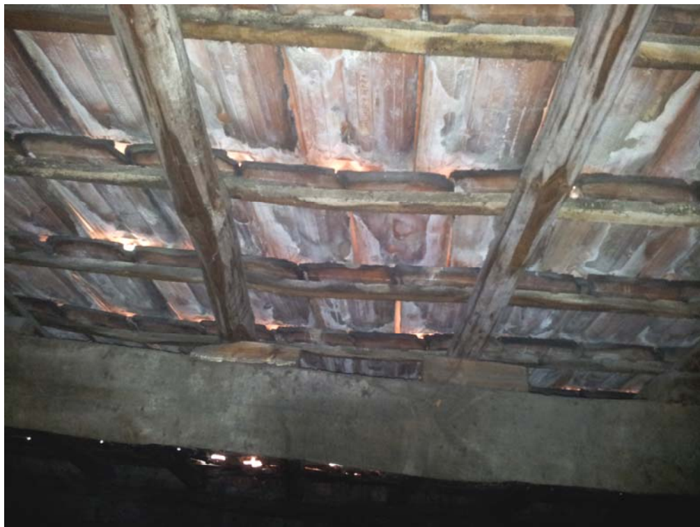
Particolare copertura corpo centrale
