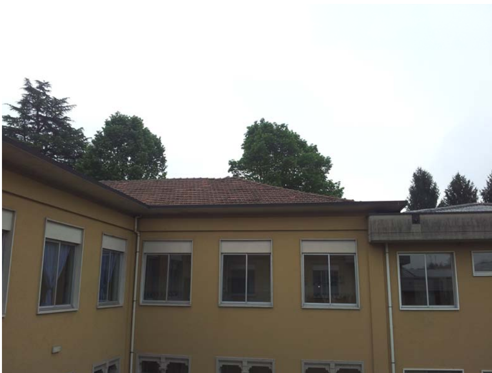
Vista copertura braccio Sud
