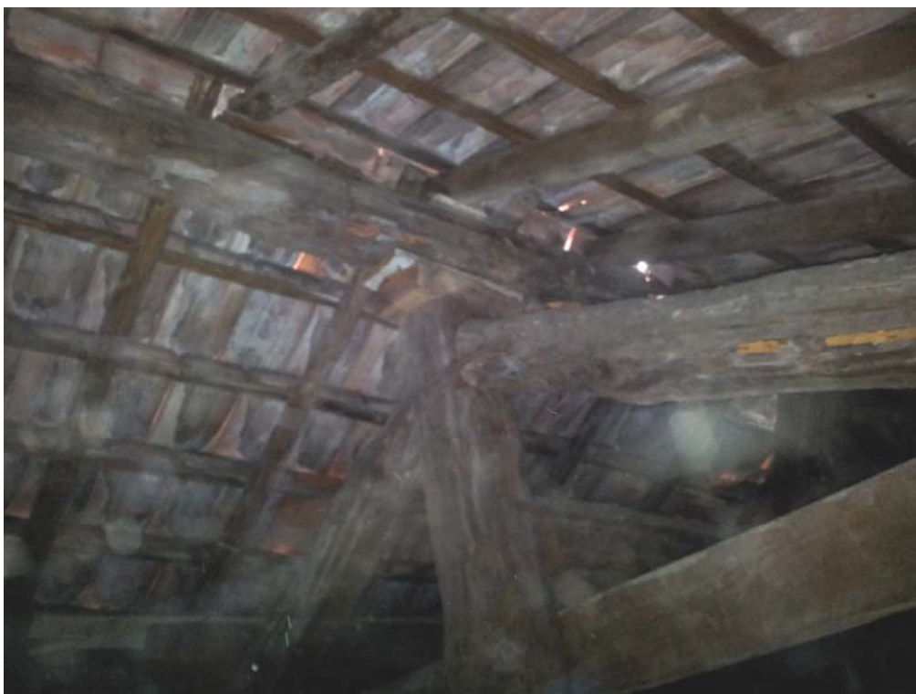
Particolare copertura corpo centrale
