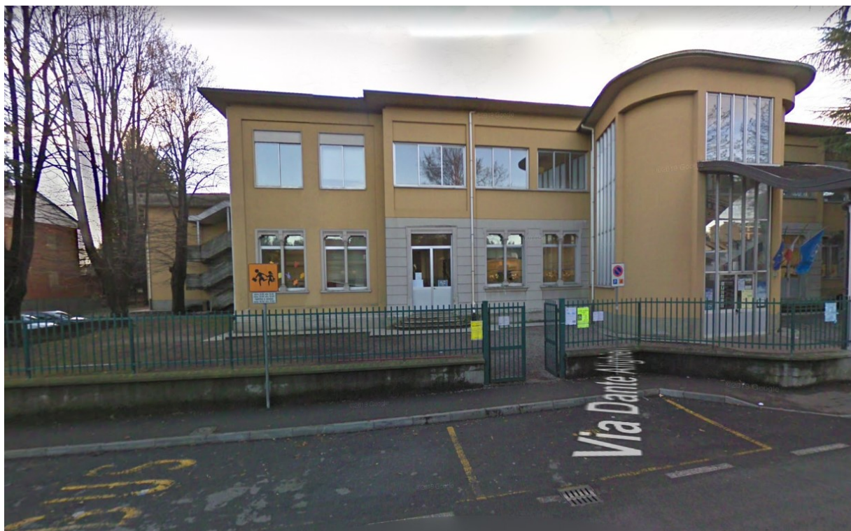
Vista facciata su via Dante
