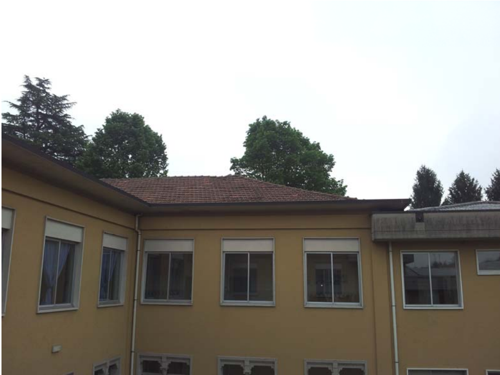
Vista copertura braccio Sud
