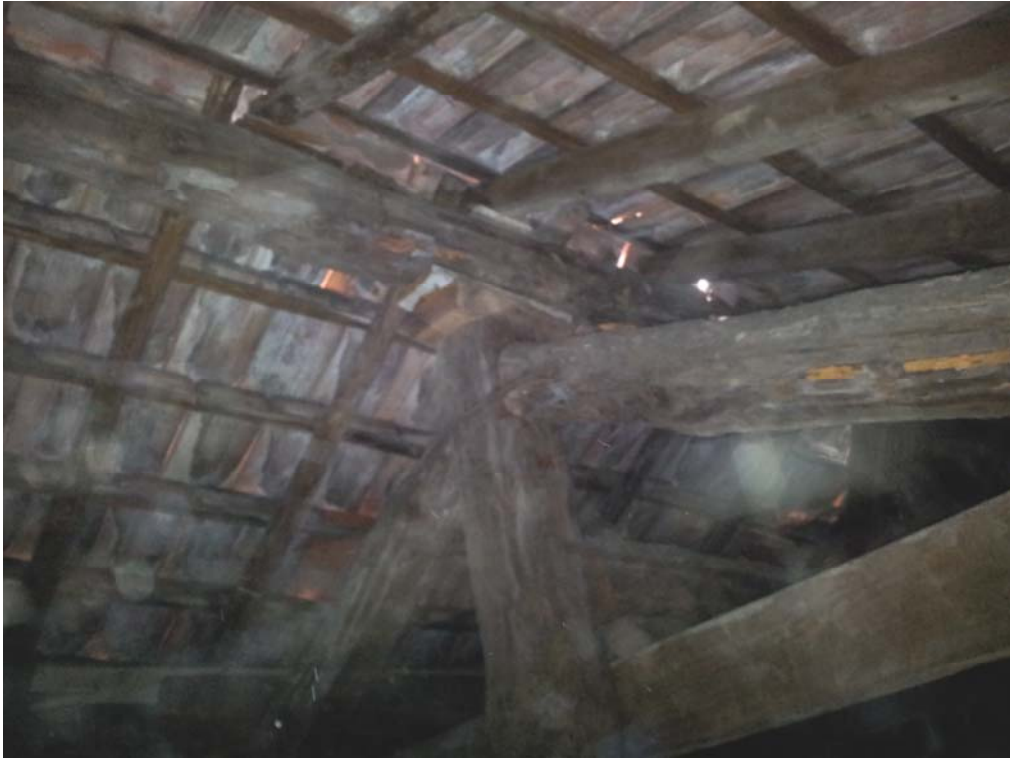
Particolare copertura corpo centrale
