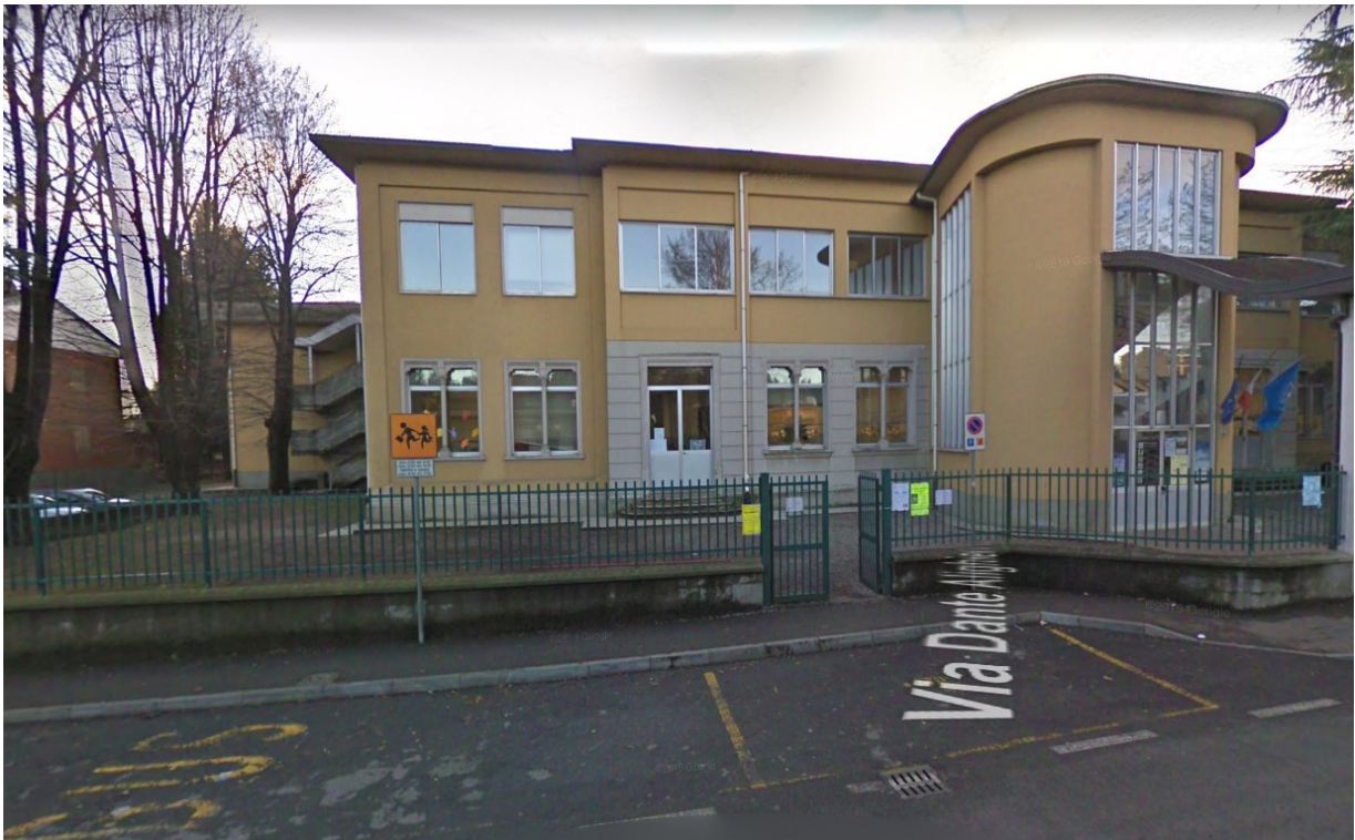
Vista facciata su via Dante
