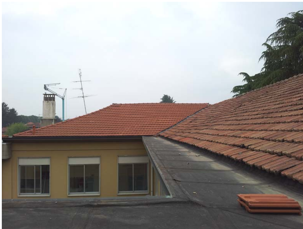
Vista copertura corpo centrale
