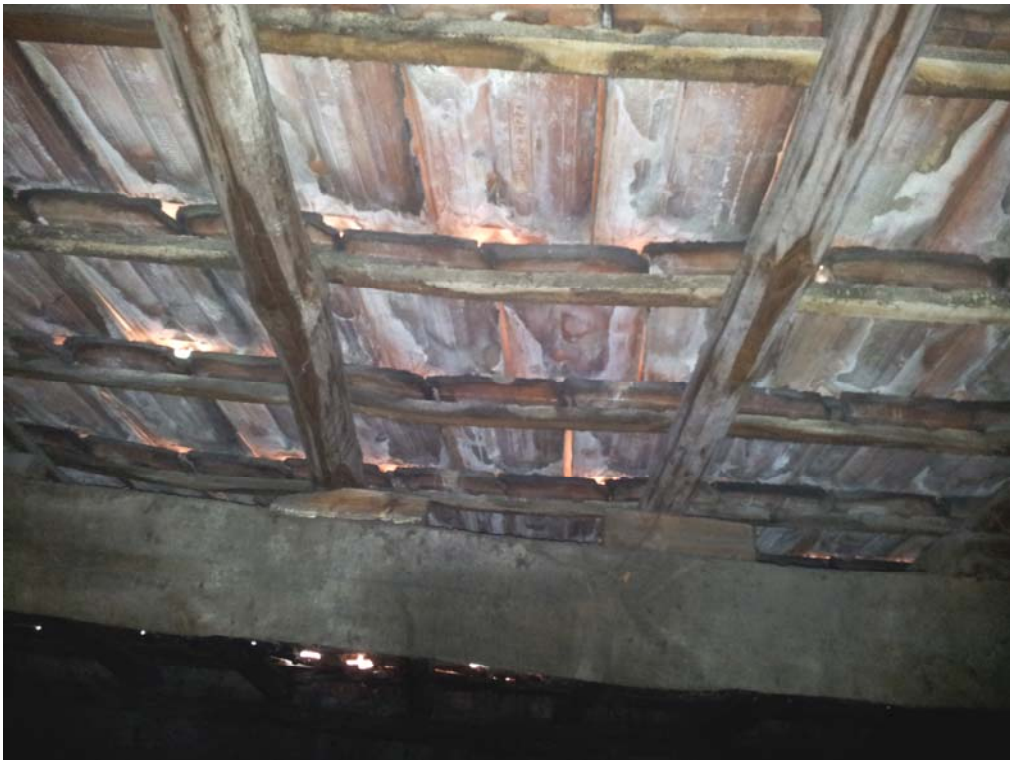
Particolare copertura corpo centrale
