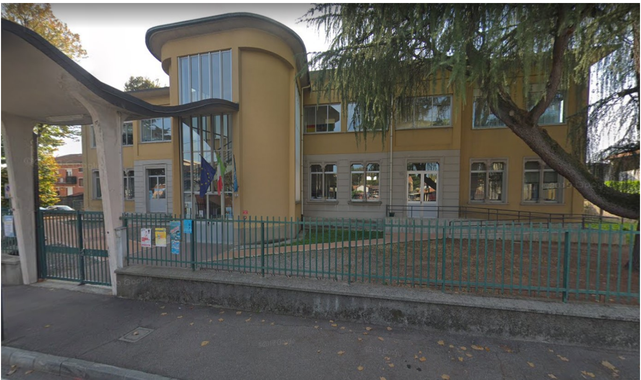
Vista facciata su via Dante
