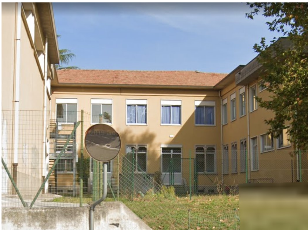
Vista facciata corpo centrale da via Leonardo da Vinci
