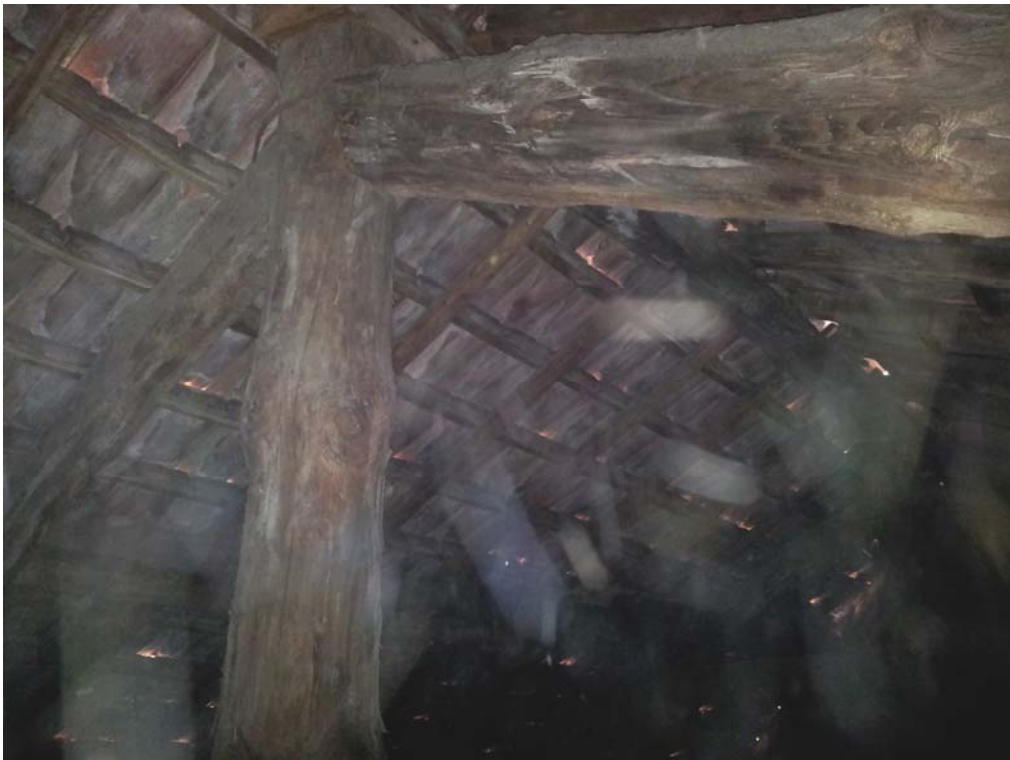
Vista sottotetto corpo centrale
