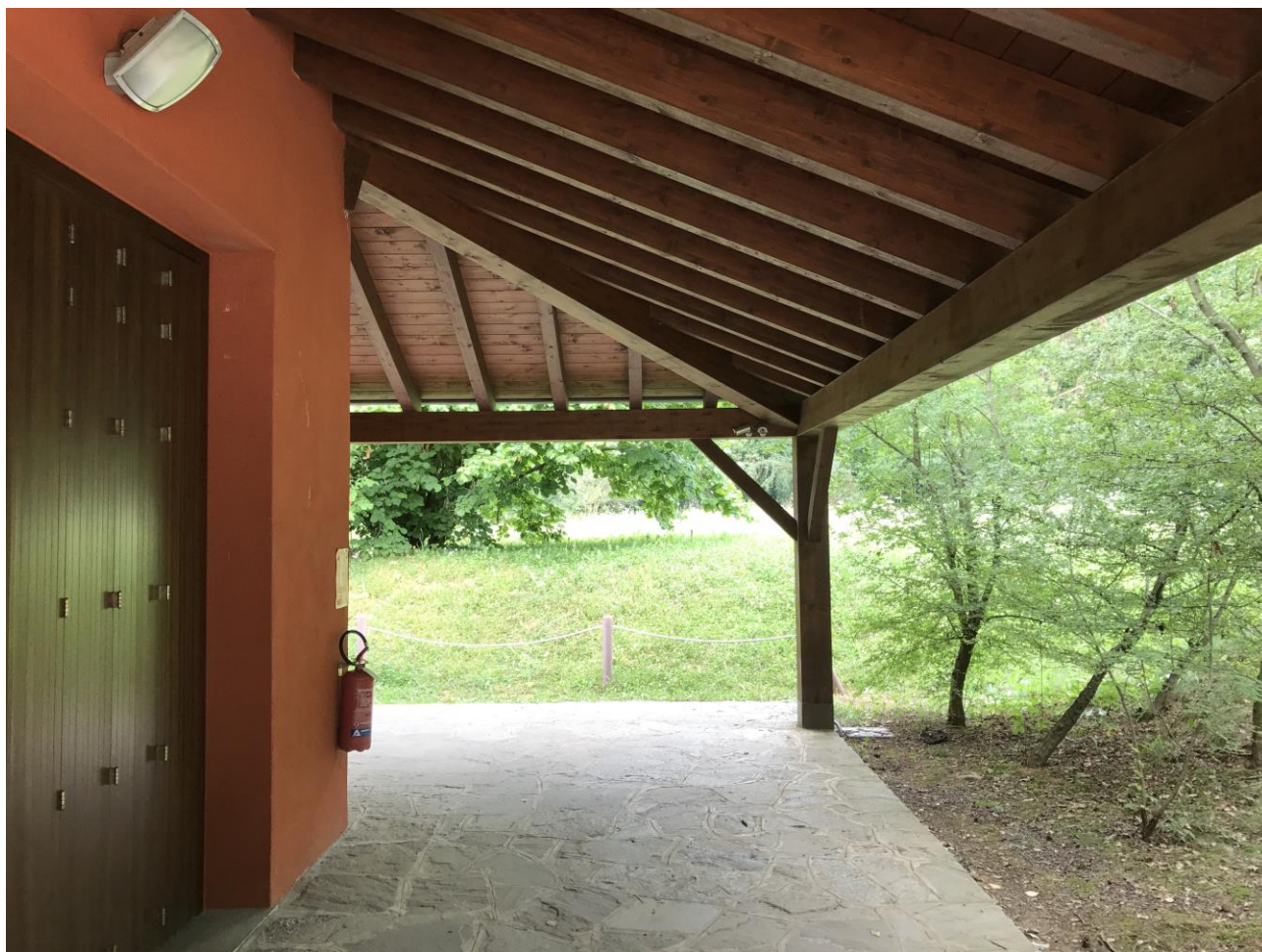
Vista con accesso dal porticato della sala convegni esistente
