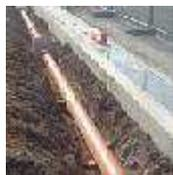
Posa tubi flessibili (PE, PVC, analoghi) e relative opere prefabbricate (pozzetti, camerette d'ispezione, pozzi perdenti e simili) per fognatura a profondità diverse. Effettuato lo scavo, vengono realizzate le armature delle pareti per interventi di profondità significativa, tramite mezzi meccanici vengono posati gli elementi prefabbricati, se necessario un lavoratore verifica il corretto fissaggio e innesto delle tubazioni nei pozzetti.
