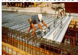
Trattasi del montaggio di solai prefabbricati a lastre tipo "Predalle" ed il completamento in opera mediante posa di armature aggiuntive, reti di ripartizione e getto di calcestruzzo.
